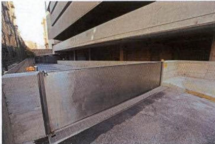
*Puerta mecánica instalada en zonas de frecuente inundación*
