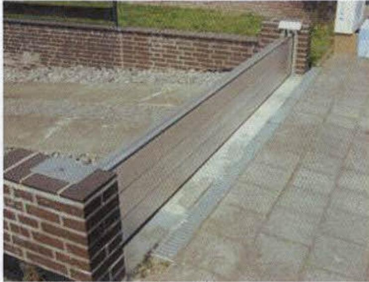
*Perfilería con lamas desmontables*
