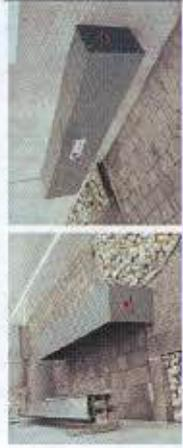
Solución mixta alternativa con Puerta submisible o manual retráctil hacia la parte trasera de la fachada, cerrada en caso de inundación, sujeta a perfiles metálicos instalados para mayor respuesta ante fuerzas de inundación.
