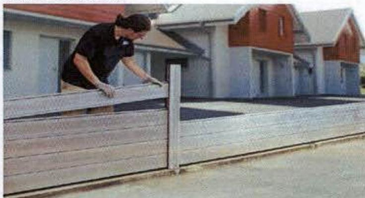
La solución anteriormente expuesta, puede ser estandarizada, o fabricada expresamente con cerrajería metálica para la incorporación de elementos estéticos más adecuados, calculada según el prisma de presiones hidrostáticas anteriormente mencionado y añadiendo cojinetes entre perfilería y lamas en caso necesario, para asegurar estanqueidad:
